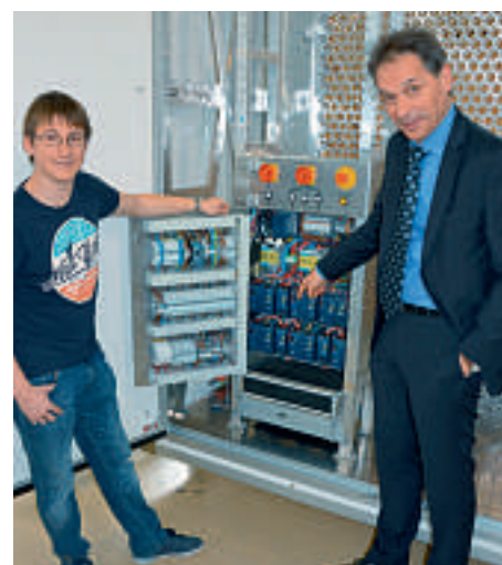
Zwei Reihen Netzteile von Puls im dicht gepackten Schaltschrank sichern den zuverlässigen Betrieb der Kameras
